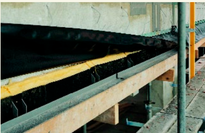
Strak metselwerk begint met secuur gemonteerde gevel-
