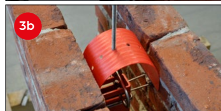
3a 3b Schuif het derde-handje over het draadeind en duw het licht naar beneden de spouw in (holle vorm). De verende werking van het kunststof trekt het draadeind rechtop. Ook is het mogelijk het derde-handje helemaal binnen de spouw aan te brengen (bolle vorm).
