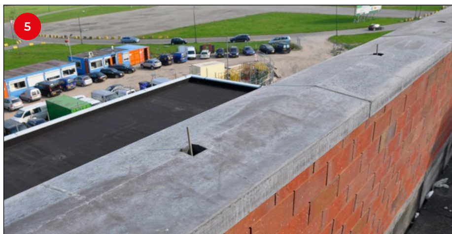
5 Door van tevoren alle draadeinden van derde-handjes te voorzien, kan het plaatsen van de afdekbanden als een routinematig en dus kostenbesparend proces worden uitgevoerd.
