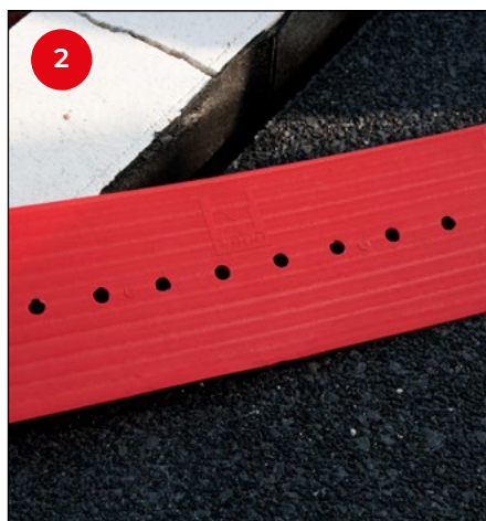
2 Pak een derde-handje en kies het gat dat zich voor de gegeven spouwsituatie het best leent.
